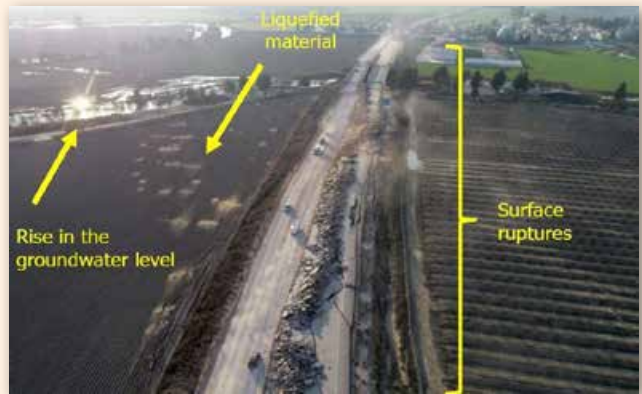
Εικόνα 7: Επιφανειακές διαρρήξεις κατά μήκος του αυτοκινητόδρομου Antakya - Reyhanlı, με ταυτόχρονη εμφάνιση φαινομένων ρευστοποίησης και ρωγμών. Επιπλέον, μεγάλα τμήματα από τα παρακείμενα χωράφια καλύφθηκαν από νερό λόγω της ανόδου της στάθμης των υπόγειων υδάτων (Lekkas et al. 2023).
