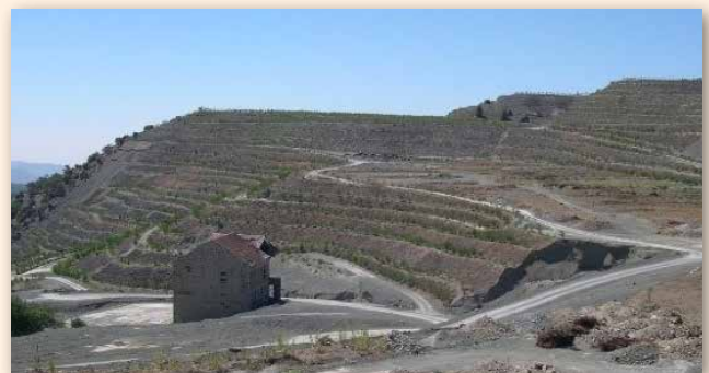
Μεταλλείο Αμιάντου - Σταθεροποίηση/ δεινδροφύτευση σε σωρούς.
