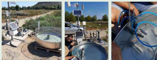
Εικόνα 3: Τοποθέτηση εξατμισόμετρου τύπου λεκάνης (αριστερά), πιεζοστατικός αισθητήρας τοποθετημένος εντός δίοδου (κέντρο), μαγνητική βαλβίδα πλήρωσης νερού (δεξιά).
