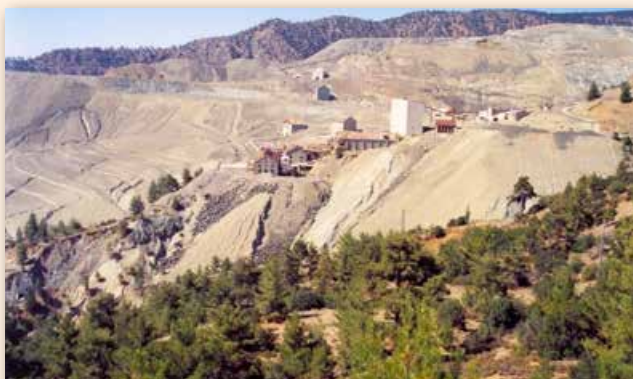
Μεταλλείο Αμιάντου - Σωροί εξορυκτικών αποβλήτων μετά το κλείσιμο του.
