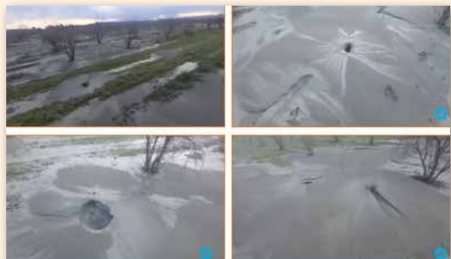
Εικόνα 8: Φαινόμενα ρευστοποίησης και υποχωρήσεις εδαφών που καταγράφηκαν στη βορειοανατολική Συρία. (Lekkas et al. 2023, https://twitter.com/MeteoredUK/status/1624076908903243778 )
