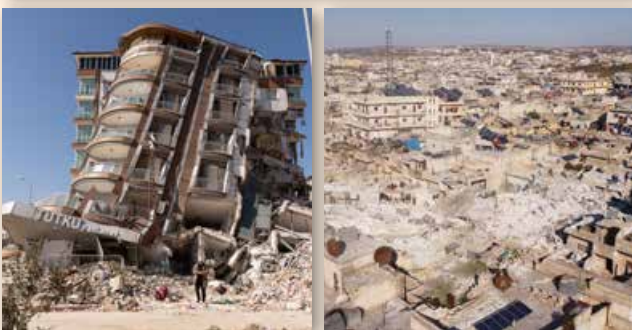
Εικόνα 5: Όλοι οι τύποι κατασκευών επλήγησαν από τους σεισμούς της 6ης Φεβρουαρίου 2023 στην Τουρκία και τη Συρία. Τα περισσότερα οικιστικά κτήρια στην περιοχή του Hatay (πάνω), στην πόλη του Kahramanmaraş (μέση) και του Αλέπο στη Συρία υπέστησαν πολύ μεγάλες δομικές ζημιές, συμπεριλαμβανομένης της ολικής κατάρρευσης για τα περισσότερα κτήρια (Lekkas et al., 2023).
