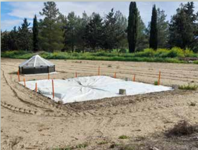
Εικόνα 2. Χώρος ξεπλύματος και ορθολογικής διαχείρισης απορροών από ψεκαστήρες.
