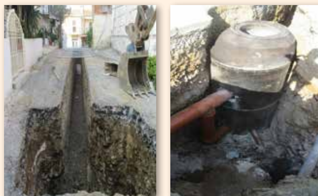
Κατασκευή Αποχετευτικού Δικτύου στην Ευρύχου, Φλάσου και Λινού
