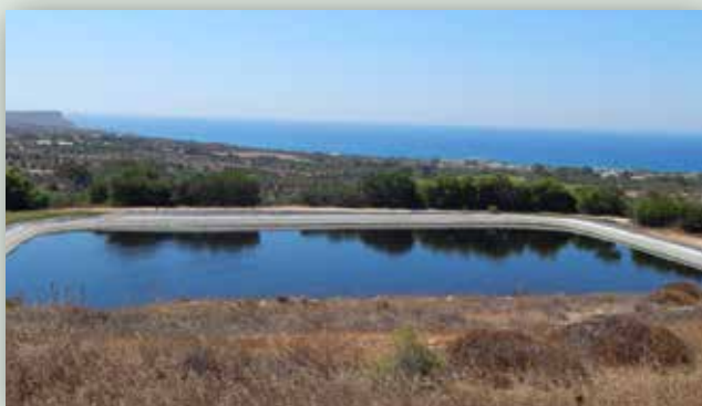
Δεξαμενή αποθήκευσης ανακυκλωμένου νερού μετά από τριτοβάθμια επεξεργασία
