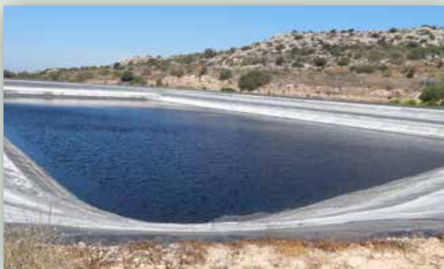
Δεξαμενή αποθήκευσης ανακυκλωμένου νερού μετά από δευτεροβάθμια επεξεργασία
