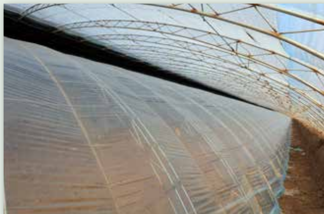
Σύστημα διπλού πλαστικού κάλυψης θερμοκηπίου
