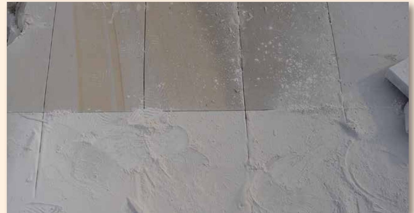
Θέση κοπής γυψομαρμάρων
