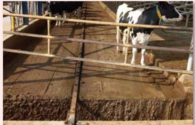
Κανάλι μηχανικής ξύστρας για τον καθαρισμό των λυμάτων
