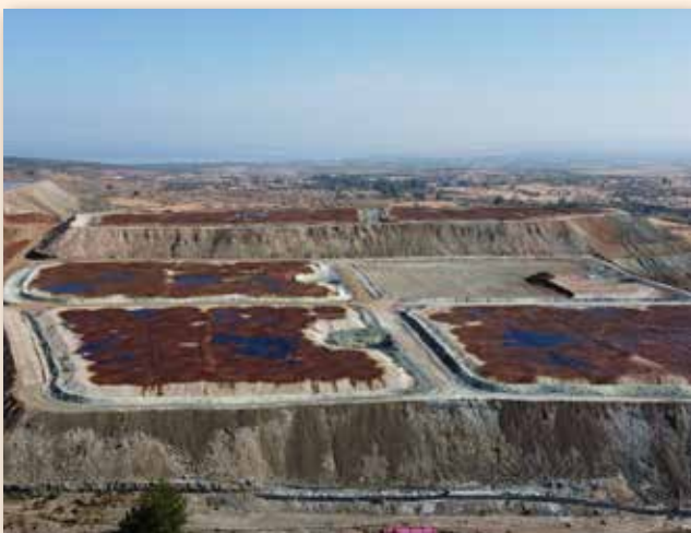
Πλατείες εκχύλισης μεταλλεύματος νικελιούχου λατερίτη
