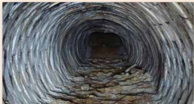
Στοά προσέλασης του υπογείου μεταλλείου της CMC.
