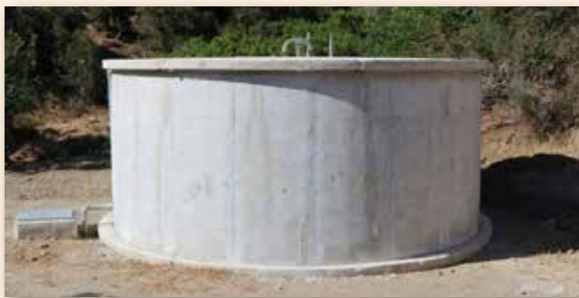
Κατασκευή υδατοδεξαμενής χωρητικότητας 90 m 3 στο Δάσος Ακάμα
