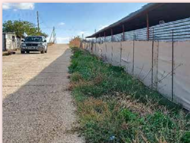
Δρόμος από οπλισμένο σκυρόδεμα στην Κτηνοτροφική Περιοχή Τίμης Β΄
