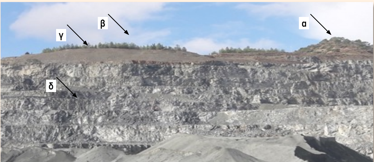
Πανοραμική εικόνα τμήματος της Λατομικής Ζώνης Παρεκκλησιάς (Νοέμβριος 2019). Διακρίνονται (α) το φυσικό δάσος, (β) η δενδροφυτεύση του χώρου όπου είχαν εξαντληθεί τα αποθέματα, (γ) η προετοιμασία του εδάφους για φύτευση, και (δ) ο δραστήριος χώρος λατόμευσης.
