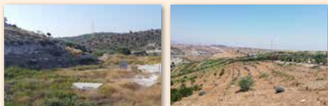
Αποκατεστημένα ΧΑΔΑ επαρχιών Λάρνακας-Αμμοχώστου και Πάφου
