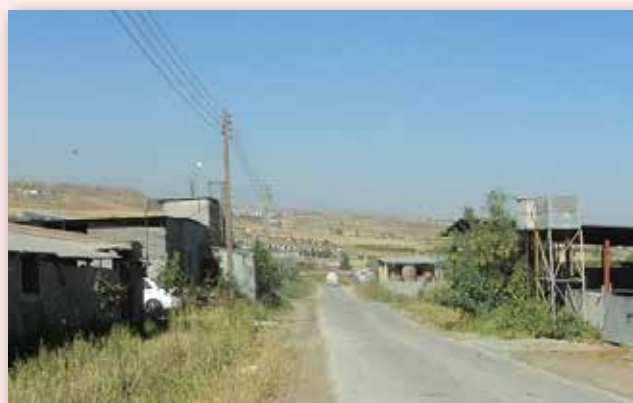
Παροχή ρεύματος στην Κτηνοτροφική Περιοχή Ξυλοφάγου
