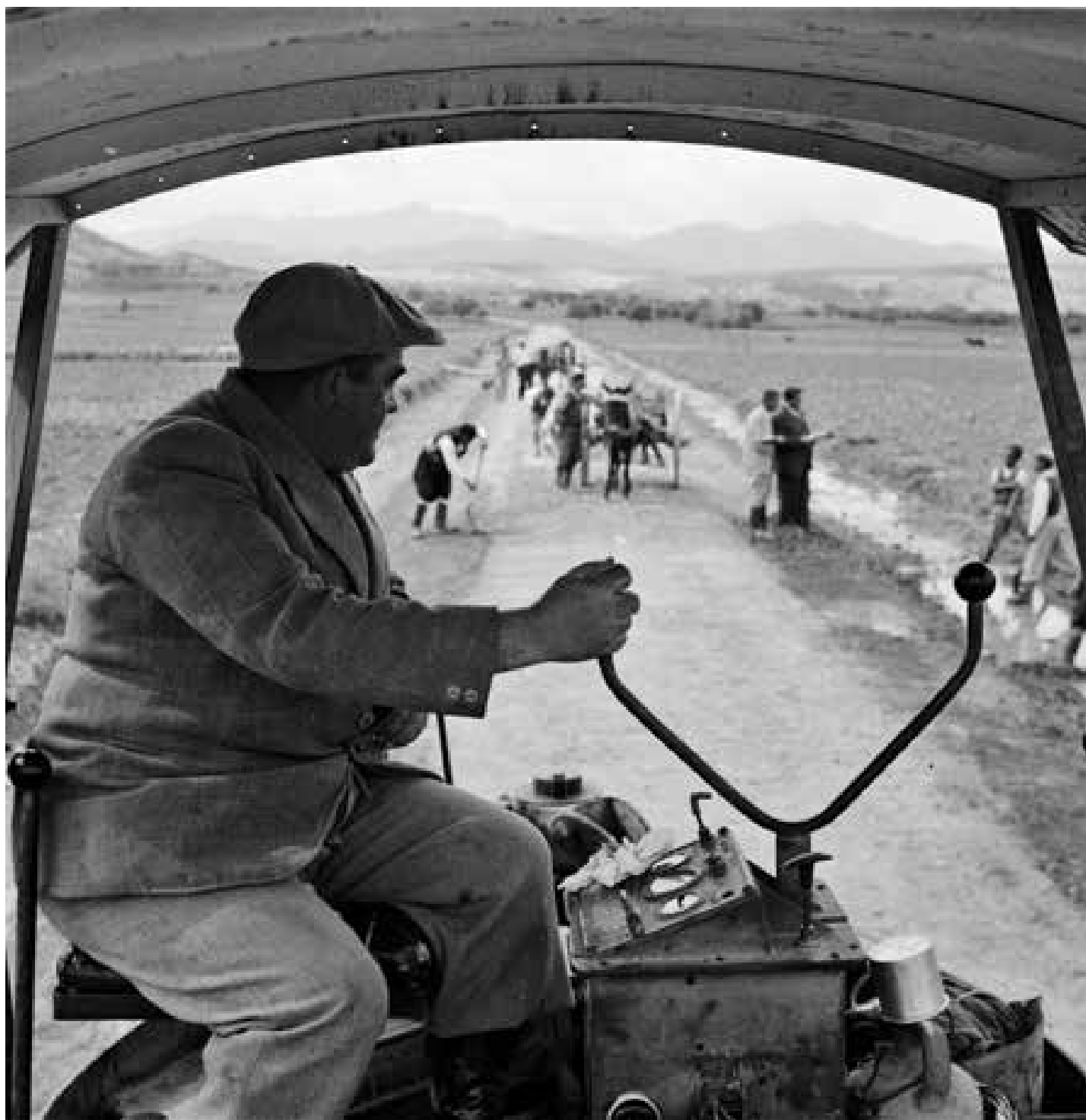
Ασφαλτόστρωση στον δρόμο της Πέγειας, 1957
